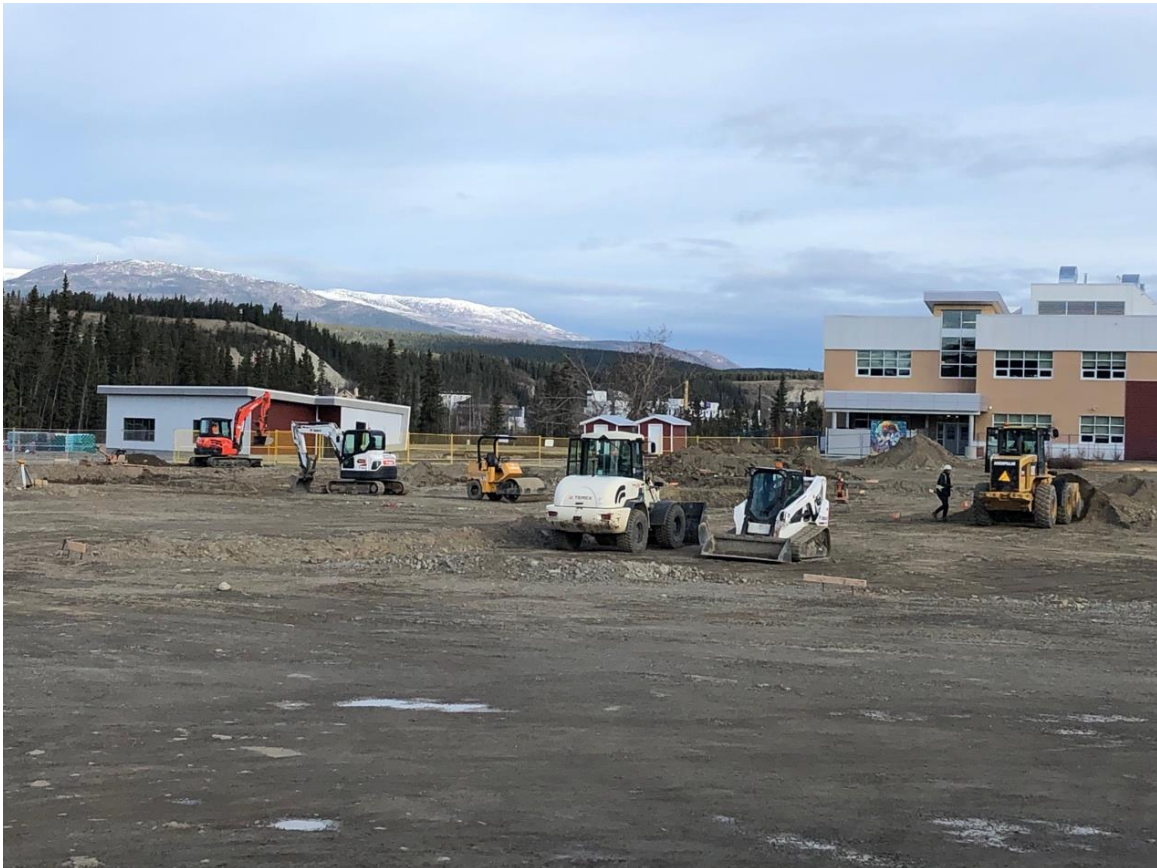
Début de la construction sur le site du nouveau Centre scolaire
